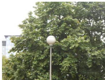
Eclairage public dont l'efficacité risque d'être fortement réduite à cause de la végétation
