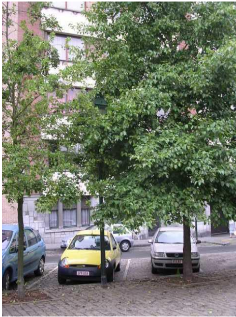
Luminaire public emprisonné dans la végétation
